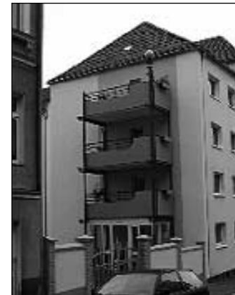
.... sowie nach der aufwändigen Neugestaltung des Giebels durch die Baufirmen.
