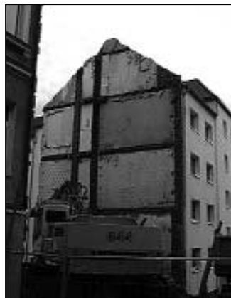
Das Haus Rähnistrasse 64 unmittelbar nach Abbruch des Nachbargebäudes...
