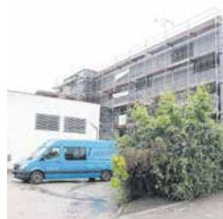
Eine neue Außenhaut an der Nordfassade hat die Festhalle erhalten. Damit haben nun alle Seiten des Plauer Kulturtempels nicht nur ein modernes Aussehen, sondern vor allem auch eine Dämmschicht. Die Löschwassereinlage in den Garderoben wird außerdem umgebaut, die Leitungen für Trink- und Löschwasser
