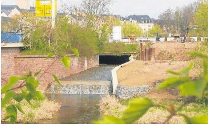
Die Arbeiten an der Syraufermauer entlang des Stadtstrandes sind abgeschlossen. Das erforderliche Geländer ist montiert. Ebenso wurde das Kreuzungsbauwerk, was die Syra über den Mühlgraben führt, fertiggestellt. Die Arbeiten waren bis Pfingsten abgeschlossen. Zu diesem Zeitpunkt plante der teilweise neugestaltete Stadtstrand die Eröffnung zur neuen Saison.
