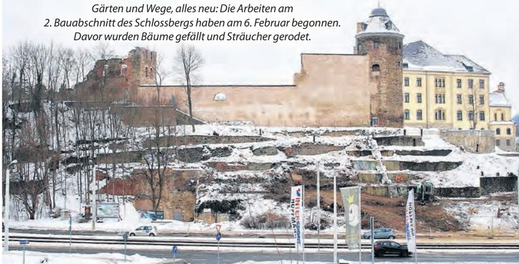
Rund eine Million Euro wird in die Maßnahme investiert, gebaut wird bis voraussichtlich April 2018. Die sichtbaren alten Mauern und Treppen im Hanggelände werden dabei komplett entfernt. „Der Hang wird anschließend neu terrassiert, das heißt, alle Mauern und Treppen werden aus Beton mit Natursteinverkleidung neu hergestellt. Auch die Wegeverbindungen auf den einzelnen Terrasenebenen werden neu gestaltet“, informiert Bürgermeister Levente Sárközy.
