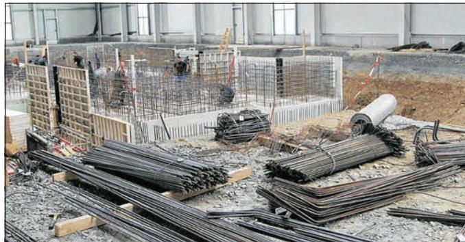
In der VCM-Halle wird das Fundament für eine Super-Fräse vorbereitet.
