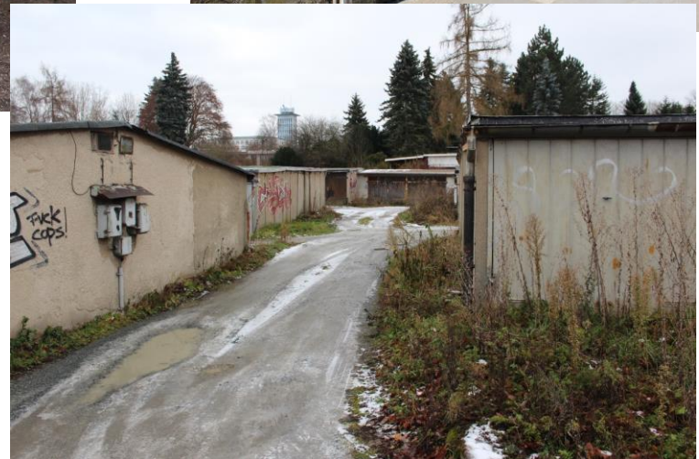
Garagenhof Haselbrunner Straße
