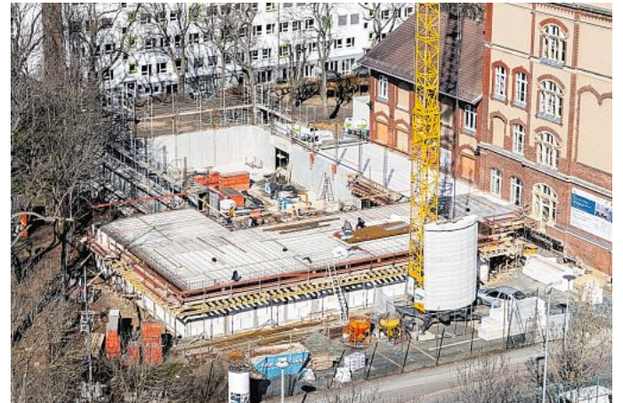
Baustand der Einfeldhalle an der Kemmlerschule von Ende Februar 2026. Foto: Oliver Orgs
