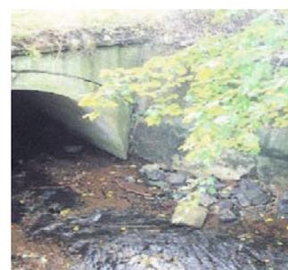
Der Syraeinlauf unter der Friedensbrücke wird ab Mitte Juni bis in den November hinein saniert. Durch die Erneuerung der vorhandenen Stützmauer und der Rechenanlage sollen die Hochwasserschäden von 2013 beseitigt werden.
