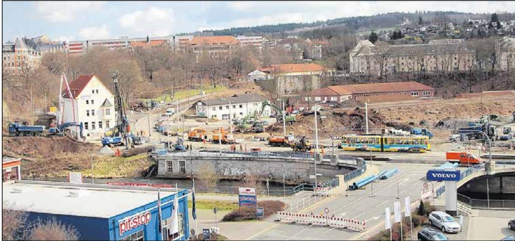
**Hochbetrieb auf der Großbaustelle Ende März. Nachdem die alte Brücke vom Plauer Unternehmen Auto Klug mit einem Riesenkran weggehoben wurde, wird nun der Bahndamm auf beiden Seiten für die neue Brücke vorbereitet.**
